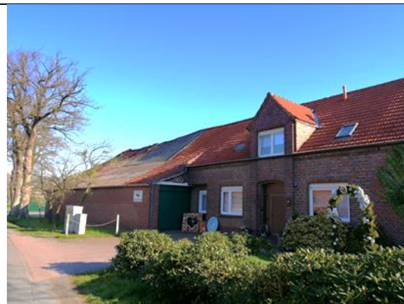
15 Wohngebäude (re) mit Stallungen (li) – Ansicht von Südwesten
