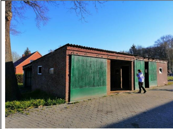
7 Geräteschuppen nördlich Stallungen außen
