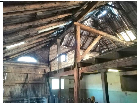
12 Stall Gesamtansicht von unten
