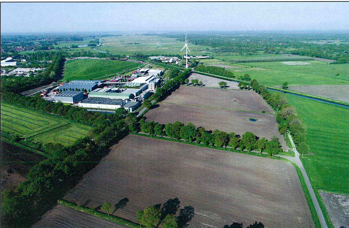
Abb. 4: Blick von Osten auf das Entsorgungszentrum (09.05.2018).
